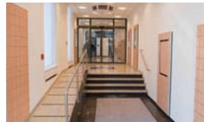
Kinderwagenrampe in der neuen Eingangssituation der Hauptfiliale Königstraße.
