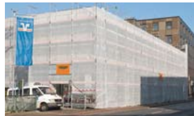
... total verhüllt während der Bauarbeiten ...
