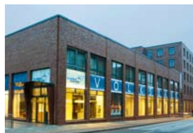
... und im neuen Glanz – dazu gehört auch die neue Lichttechnik.
